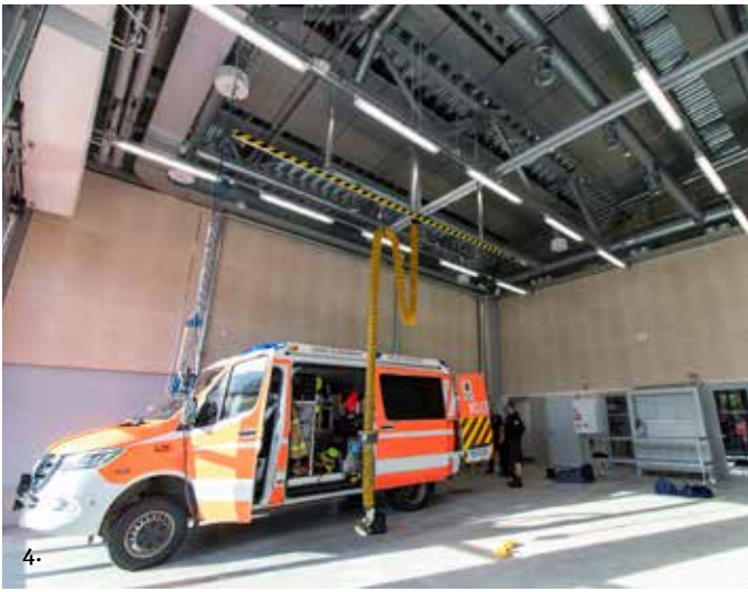
Kuva 4: Kalustohallit ovat teräsrunkoisia ja rakenteet ovat näkyvässä erityisesti katon teräsristikoissa.
