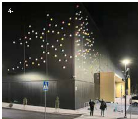
Kuva 4: Uuden areenan käyttötarkoituksen ilmentävä julkisivu, johon tehty palloaiheinen taideteos tulee parhaiten esille Ruukin toimittamista mustista elementeistä pimeässä teoksen ilta-valaistuksessa. Palloilun nimisen teoksen takana on kuvanveistäjä ja ympäristötaiteilija Jaakko Himanen. Areenan arkkitehtisuunnittelusta vastaa Arkkitehti-toimisto 3Design Oy.
