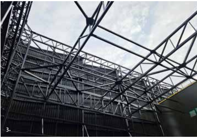
Kuvat 3–4: Pektran urakoimat teräsrakenteet luovat vahvan rungon uudelle Salmisaaren ilma-vesilämpöpumppu- ja sähkökattilalaitokselle eli C-yksikölle. Yksikkö seisoo tukevasti paikoillaan SSAB:n toimittamien teräspaaluojen päällä.
