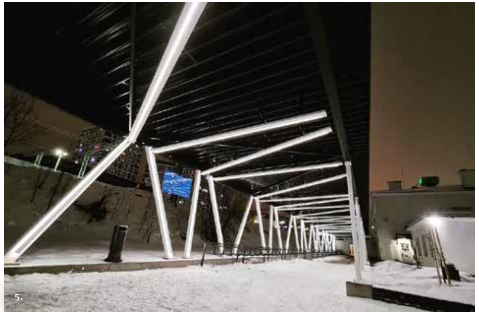
Kuva 5: Kuopion aseman uutta teräsrakenteista katosrakennetta.
