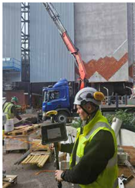
Kuva 2: Uuden C-yksikön rakentamisessa on alueen ilmeikkään teollisuusarkkitehtuurin lisäksi haasteena ollut ahdas tontti, joka nykyisin rajautuu kiinni urbaaniin ympäristöön. Tästä on seurannut rajoitteita mm. laitoksen sallittuun melutasoon sekä työmaan toimintaan. Keskeisen sijainnin takia ja rakennuslupaprosessin sujuvan edistymisen varmistamiseksi oli välttämätöntä ottaa Swecon arkkitehdit mukaan laitoksen suunnitteluun jo hankkeen varhaisessa vaiheessa.
