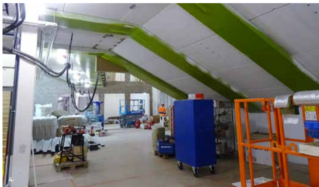
Kuva 4: Portaiden alla ei ole pilareita.
