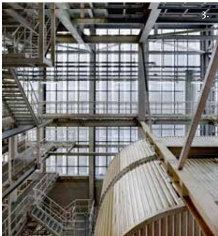
Kuva 3: Uuden biolämpölaitoksen rakennukset ovat pääosin teräsrunkoisia. Lisäksi terästä on käytetty paljon erilaisissa täydentävissä rakennosissa kuten portaat, tasot ja kaiteet sekä itse prosessilaitteissa ja esimerkiksi prosessiin liittyvissä putkissa ja putkikannattimissa.
