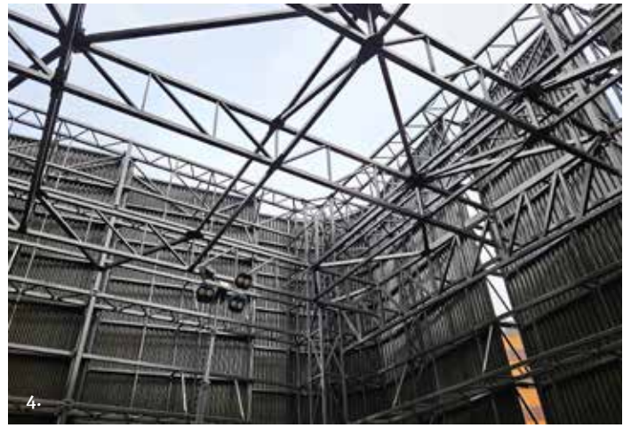
Kuvat 3–4: Pektran urakoimat teräsrakenteet luovat vahvan rungon uudelle Salmisaaren ilma-vesilämpöpumppu- ja sähkökattilalaitokselle eli C-yksikölle. Yksikkö seisoo tukevasti paikoillaan SSAB:n toimittamien teräspaaluojen päällä.
