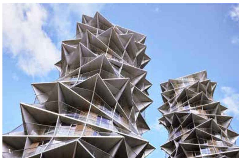
Kuva 1: Etelä-Tanskassa sijaitsevaan Esbjergin kuntaan on rakennettu kolme upeaa kaktuksen muotoista tornia. Tornien omaleimainen ilme on luotu kuumasinkitystä teräksestä valmistetuilla parvekkeilla.
