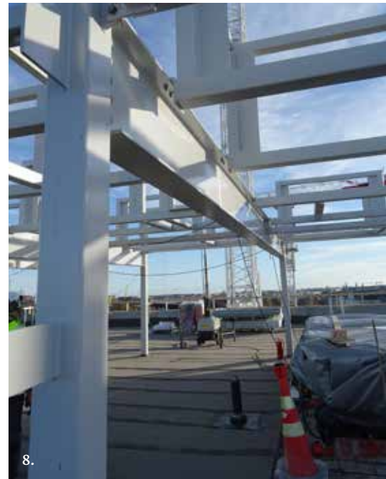
Kuva 8: Mittavien IV-konehuonetilojen runkorakenteita.
