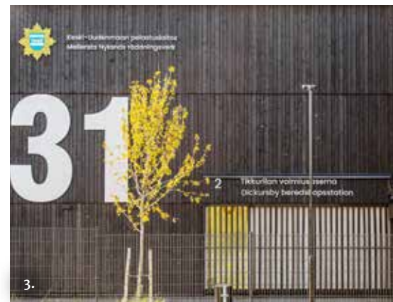
Kuva 3: Hiillytetty puu asennettiin saumoistaan limitettynä.
