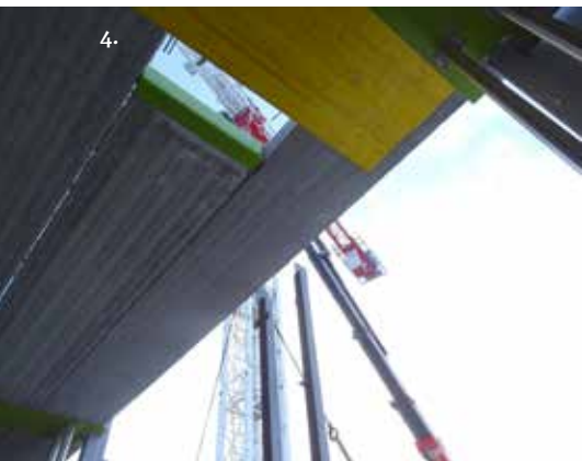
Kuva 4: Petra Green -laattakannake valmiina paikallaan.
