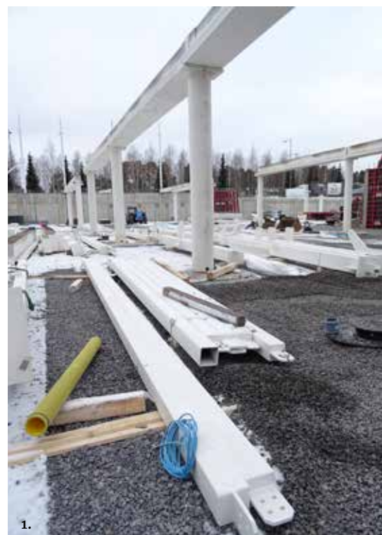
Kuva 1 ja 5: K-Supermarketin parkkihalliin tulee järeä WQ-palkisto.
