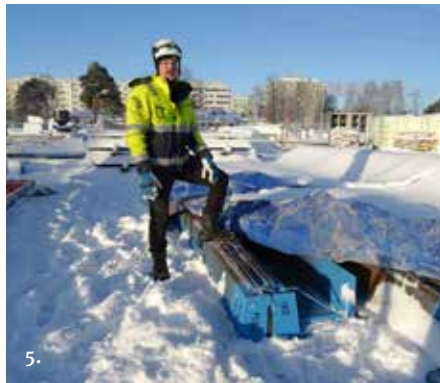
Kuva 5: Työnjohtaja Ville Mestari esittelee Anstarin valmiiksi valettuja palkkeja, jotka olivat jo saapuneet työmaalle odottamaan asennuksia.
