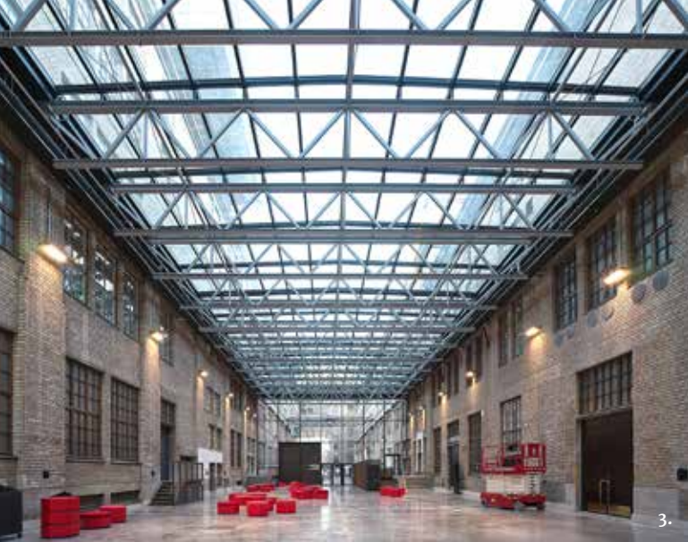
Kuva 3: Kaapelitalon sisäpihan lasikatto tuo lisää tilaa yleisötapahtumiin.
