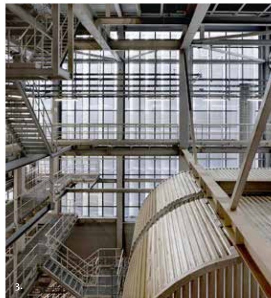
Kuva 3: Vuosaaren uuden biolämpölaitoksen teräsrakenteita.
